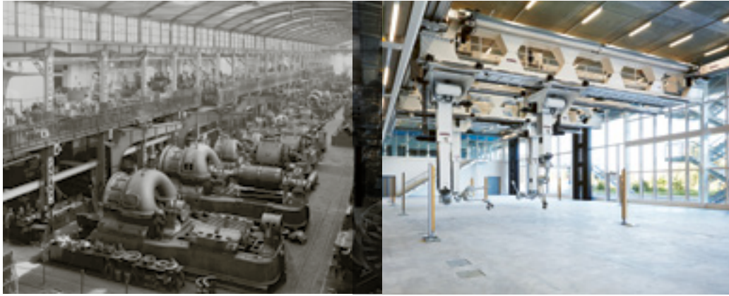
Imposante Hallen und Favoriten der Gesprächspartner: die AEG-Turbinenhalle (links) und die Roboterhalle des Arch_Tech_Labs.
