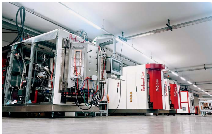
Construction d'installations et revêtement spécialisé à Rüthi (Rheintal)
