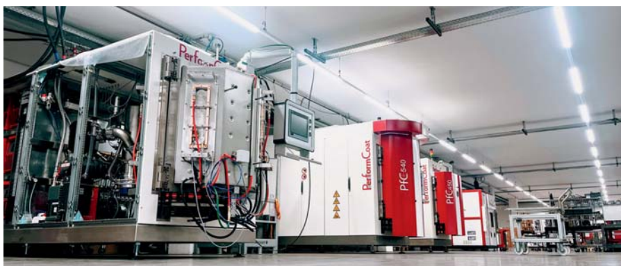
Anlagenbau und Lohnbeschichtung in Rüthi (Rheintal)
