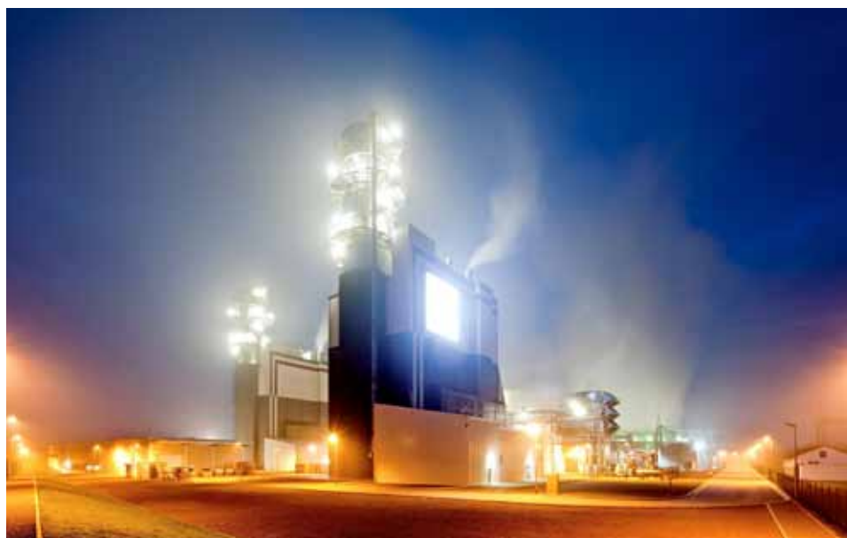
850 Megawatt Spitzenleistung: In Hamm, Nordrhein-Westfalen, wird Strom aus Gas und Dampf erzeugt.
